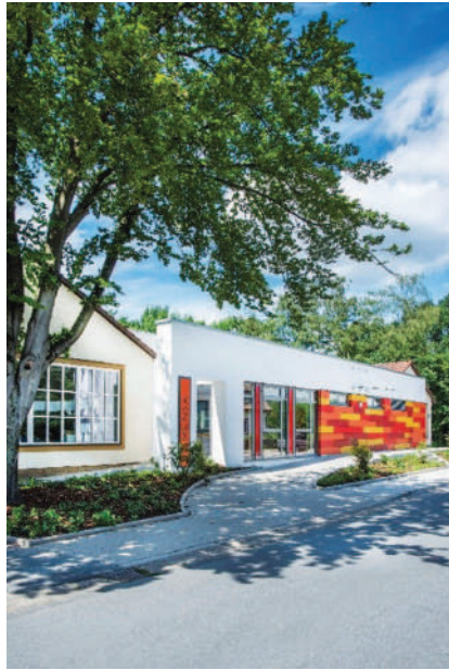
Abb. 2: Außenansicht der neuen Mensa.
